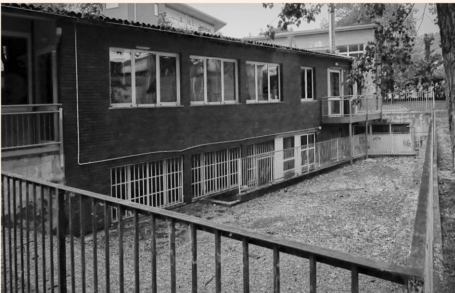
Zona seminterrata lato est
