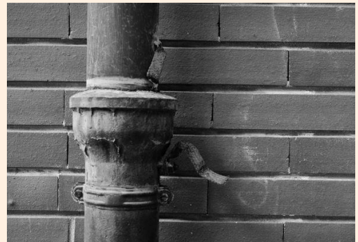
particolare di un pluviale
